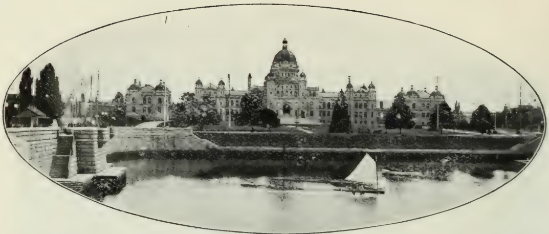
Vue des bâtisses du Parlement provincial de la Colombie Anglaise, à Victoria.
